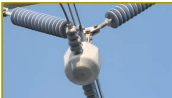
Splidsning på Rømø dæmningen.
